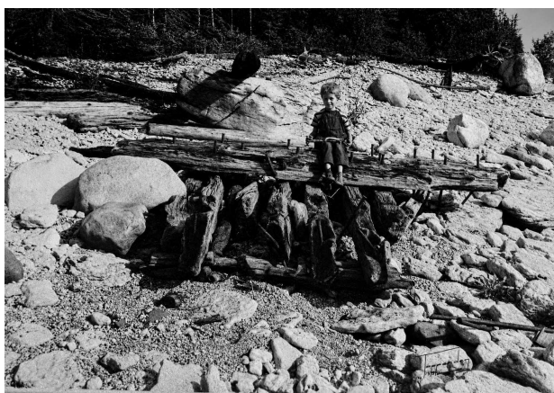
Zdjęcie wraku wykonane w 1932 roku przez Richarda Tappendona z jego synkiem siedzącym na nadstępcie. (Nadstępką to wewnętrzna belka wzmacniająca).
