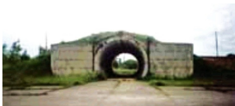
Tak zwany Granit – ukrycie z żelbetonu w kształcie rury obsypanej ziemią.
